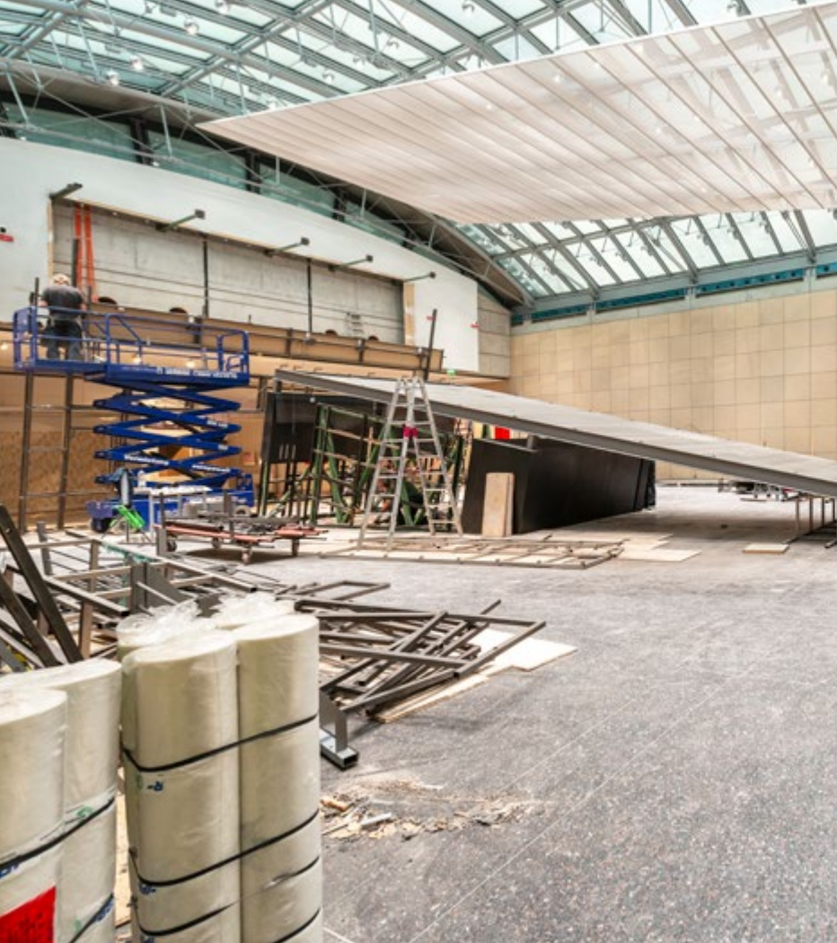
Hebebühne, Rampen und Gerüste – die Abrissarbeiten in den Ausstellungshallen sind komplex, und strenge Sicherheitsvorkehrungen sind erforderlich.
