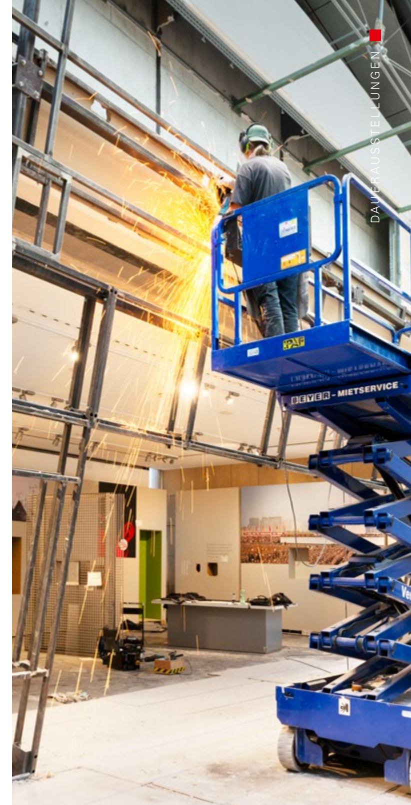
Auch Flexarbeiten sind notwendig, um die Ausstellungsarchitektur abzubauen.
